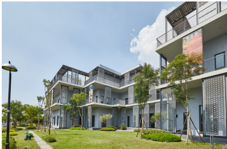
舊振南綠建築總部
